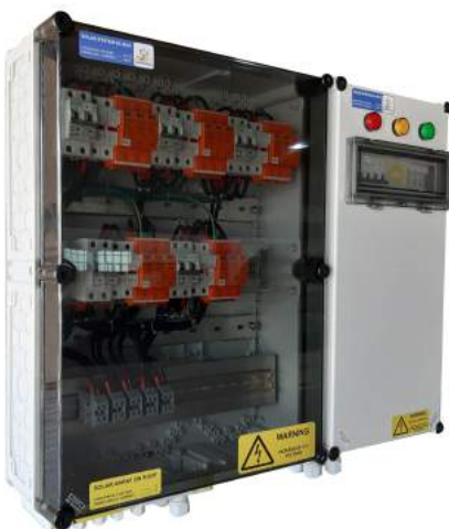
Tủ Điện ASP
