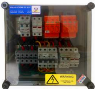
Tủ Điện ASP
